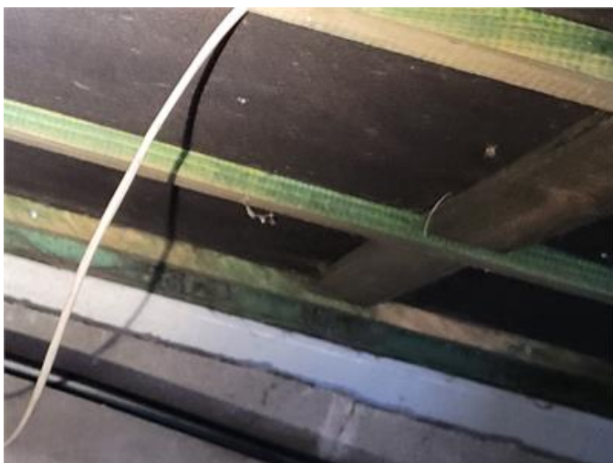
Tryckimpregnerat virke förekommer i golvbjälklaget.
