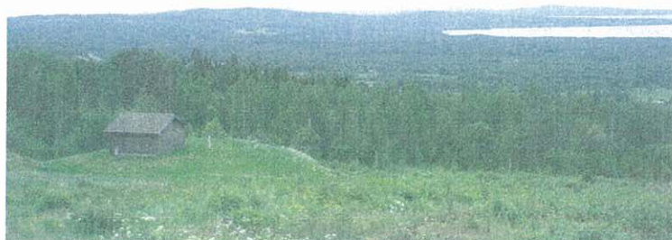
Tryckstegringsstation med vacker utsikt
