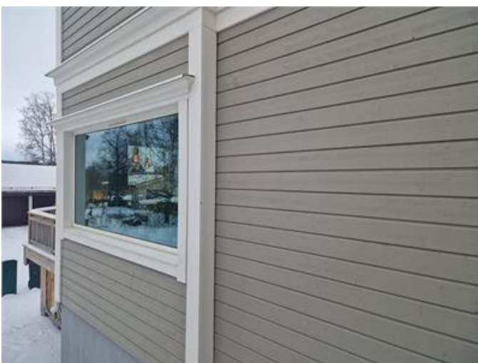
Fasad och fönster.
