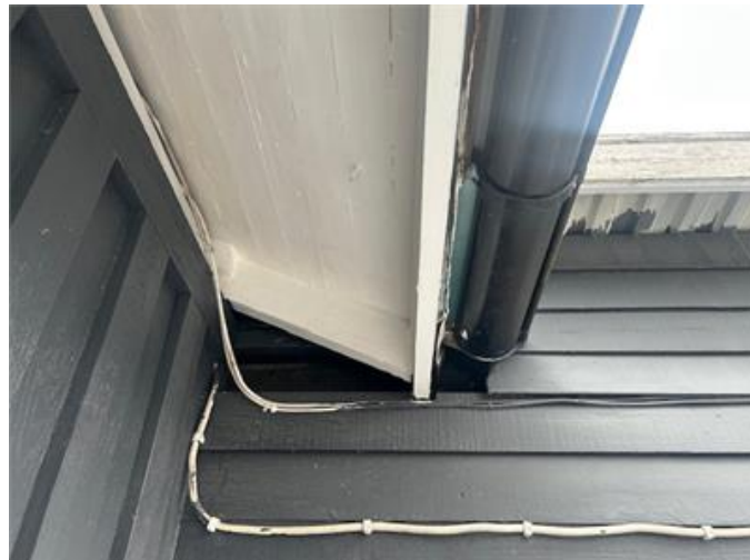
Exempel på otätheter i fasad.
