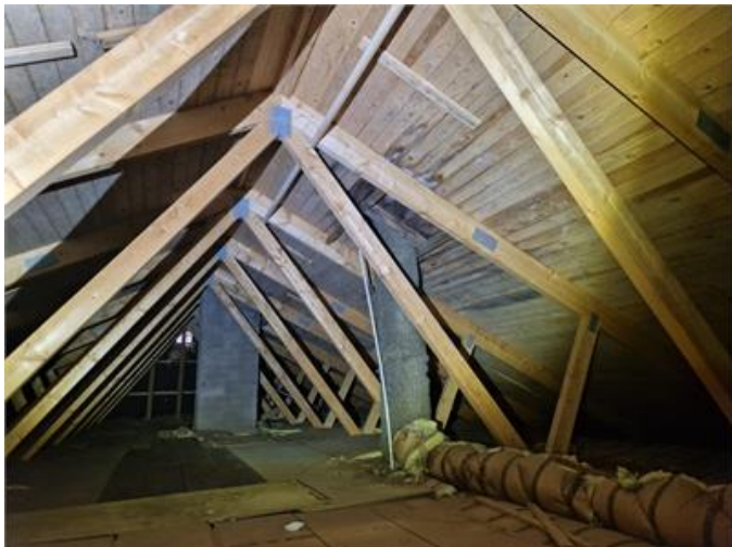
Vy på vindsutrymmet
