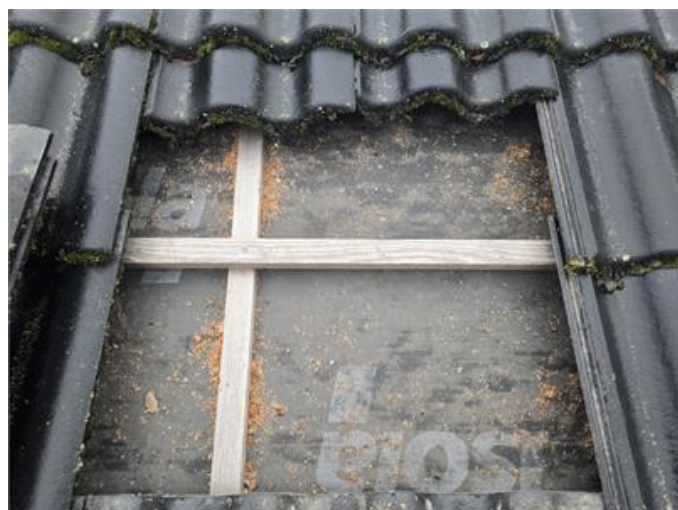
Tak: Stickprovskontroll under pannor.
