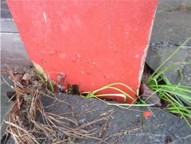
Röta i ändträ på träpelare
