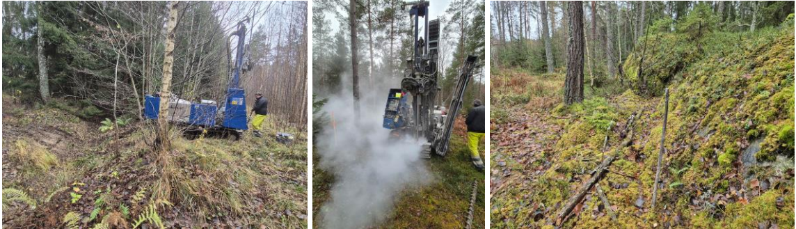
Bild 1.2.1 - 1.2.3: Vänster bild visar sondering i borrhpunkt 112 invid ett av de befintliga diken i området. Mellersta bilden visar sondering i borrhpunkt 118 där berget ligger nära befintlig markyta. Höger bild visar hur berget lokalt kommer upp så som en bergsvägg med ca 1,5 – 2 m höjd straxt söder om planområdets gräns nära borrhpunkterna 108 och 109.
