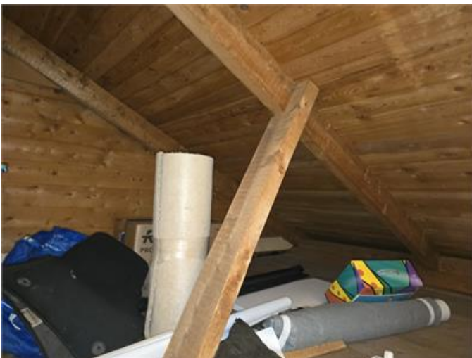
Överblick del av vinden.
