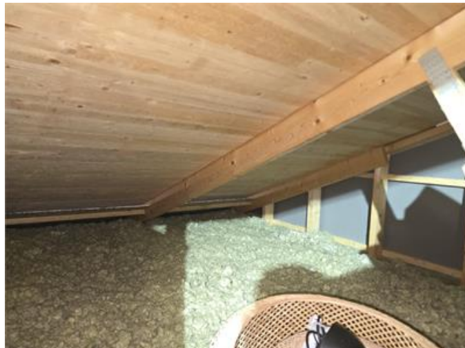
Överblick del av vinden.
