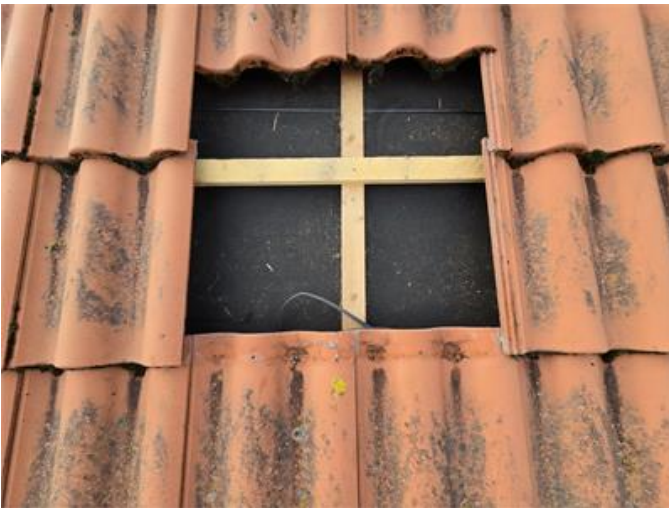
Tak: Stickprovkontroll under pannor.
