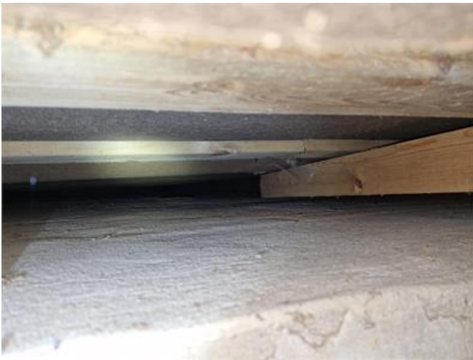
Plintgrund utbyggnad norra delen.
