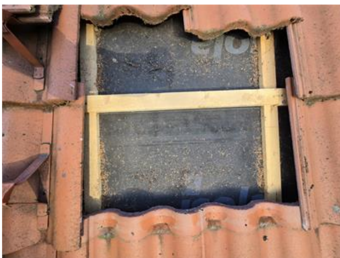
Tak: Stickprovskontroll under pannor.
