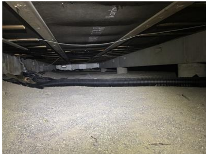
Översiktsbild av krypgrunden.
