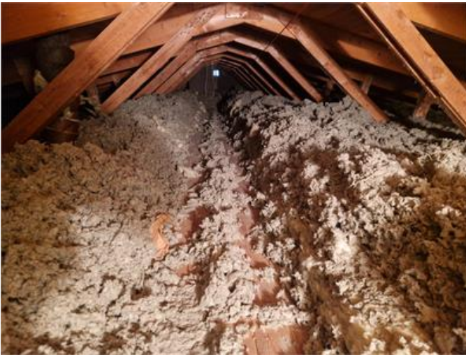
Vy på vindsutrymmet
