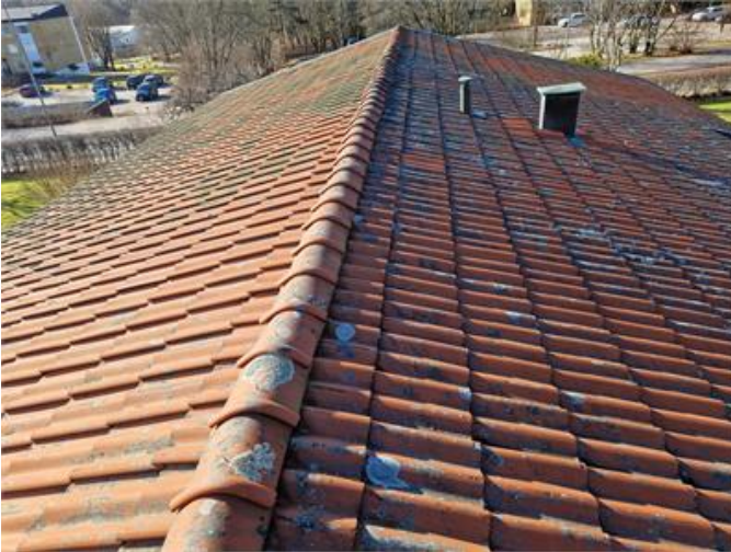
Vy på yttertak
