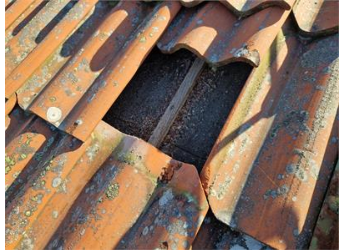
Vy på underlagstak
