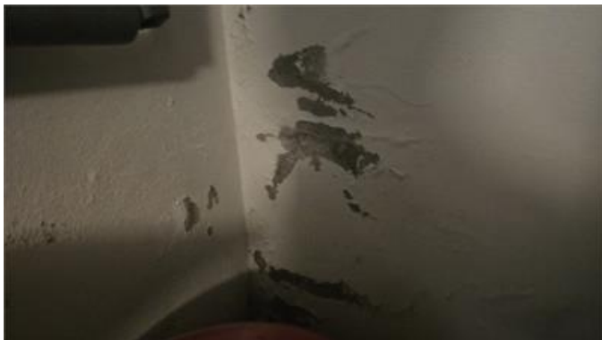
Exempelbild, färgsläpp källarvägg.
