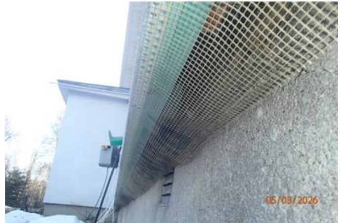
Bild på fasad konstruktionens utförelse med luftspalt.
