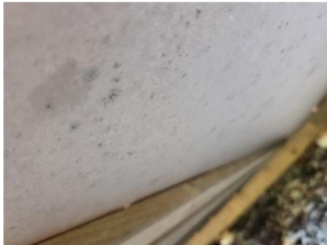
Mikrobiell påväxt på blindbotten.
