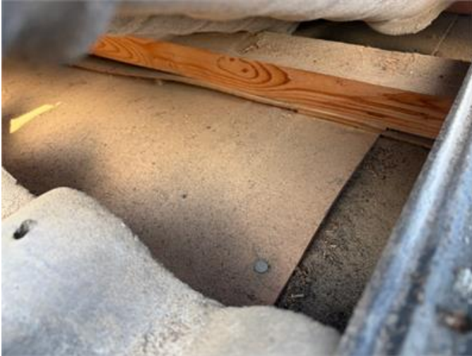
Stickprovskontroll av läkt och undertak (board) utförd utan något att anmärka på
