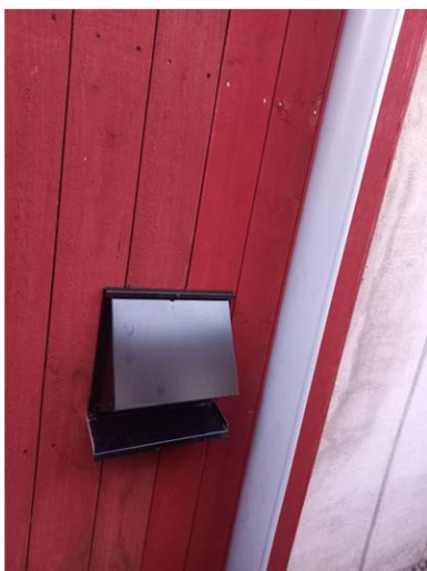
Revidering/Åtgärd: Åtgärder utförda vid frånluftsventil från krypgrund.
