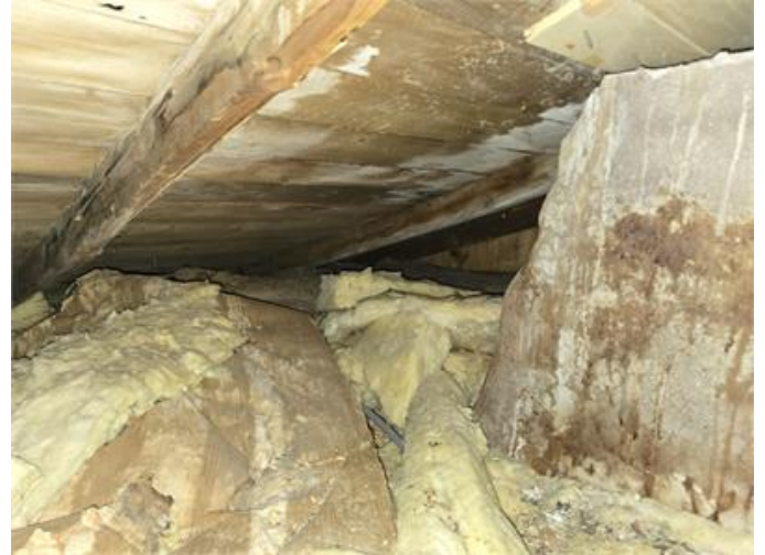
Exempel från del av vinden.
