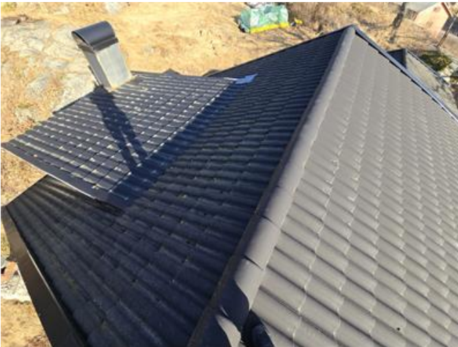
Överblick del av yttertak.
