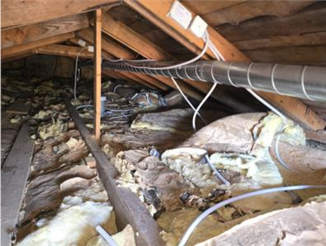
Överblick del av vinden.
