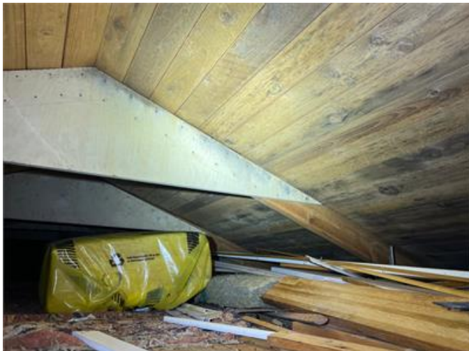
Bilden visa del av vindsutrymmet.
