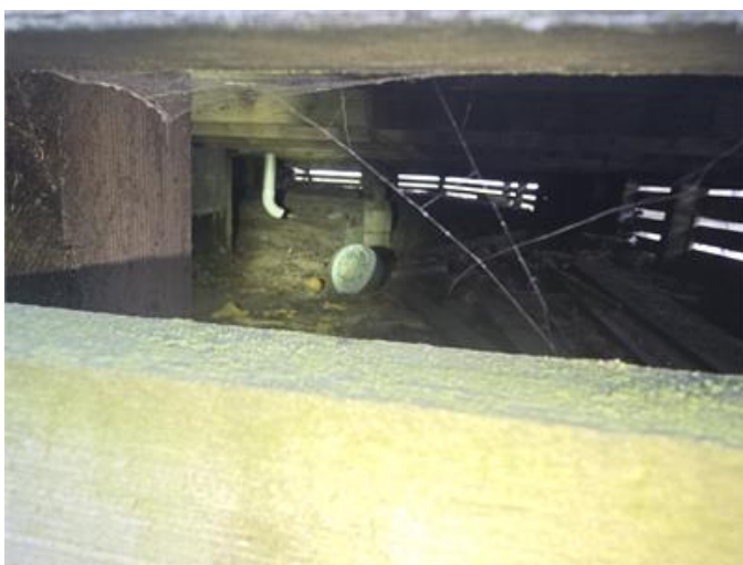
Stuprör under altanen.
