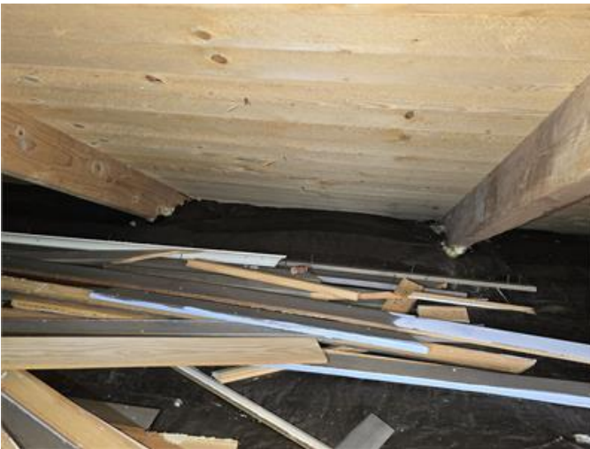
Nockvind: Isolering ligger an mot underlagstak vid takfot.
