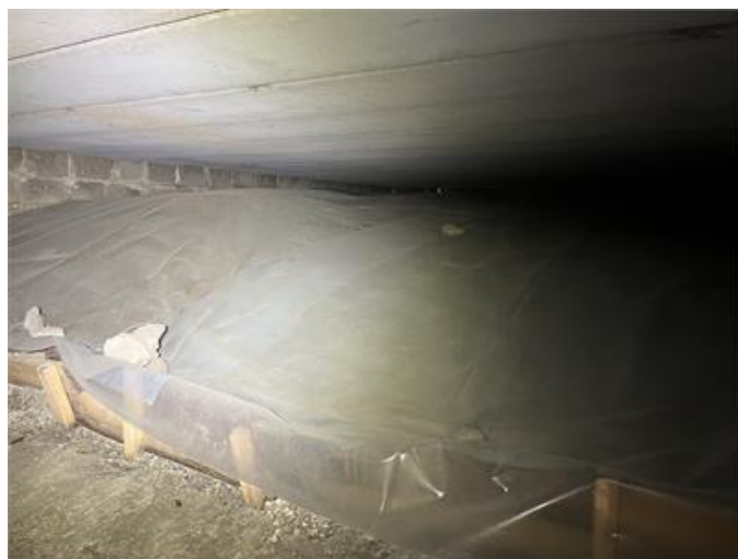
Bild från krypgrunden
