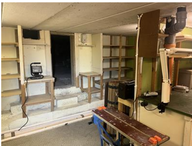
Bild från krypgrunden
