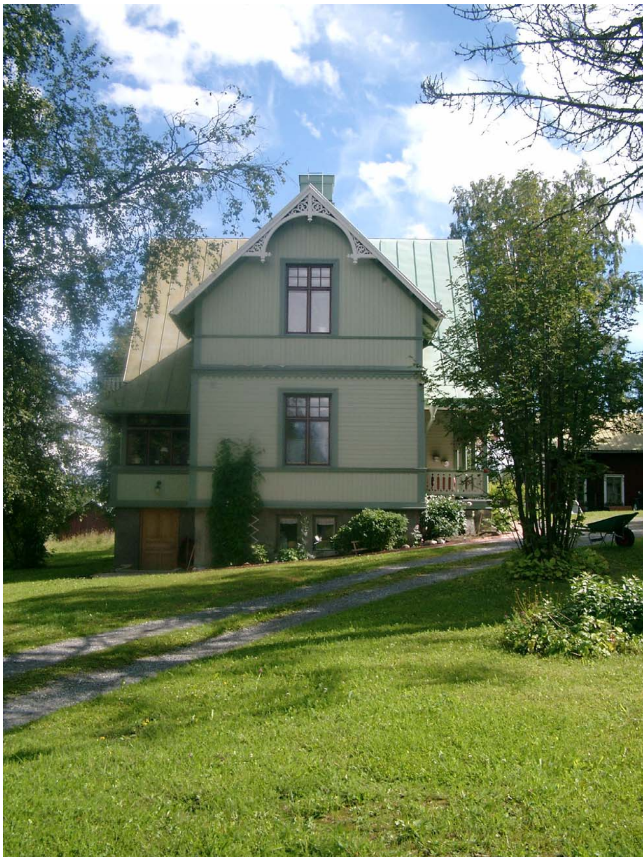
Solbacken. Härke 1:11. Kulturhistoriskt värdefull bebyggelse från tidigt 1900-tal. Restaurering pågår.
