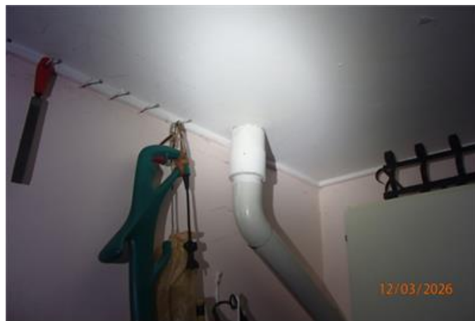
Bild på genomföring i garaget från takbrunn
