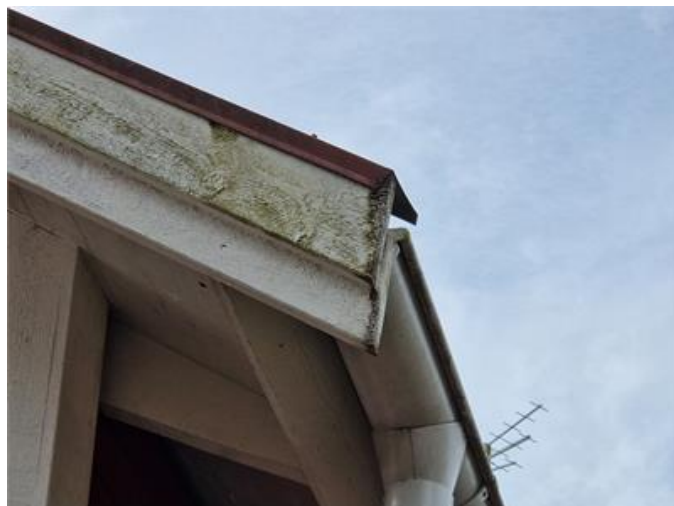
Tak: Vattplåtar något korta mot vindskivor.
