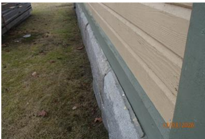
Husvägg innanför grundmuren
