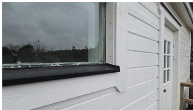
Montage av fönsterkassett källarrum.
