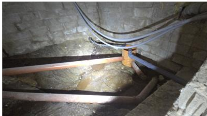
Pumpgrop/brunn för dagvatten placerad i krypgrund, fritt vatten på berg.
