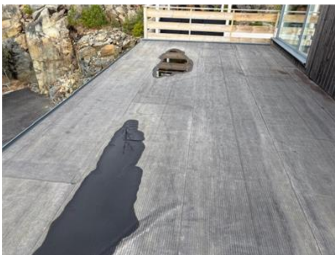
Bilden visar vy av tak (garage).
