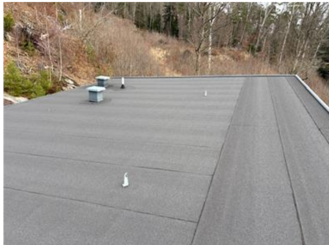
Bilden visar vy av tak (huvudbyggnad).
