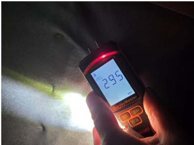
Bild från krypgrund under duschrum.
