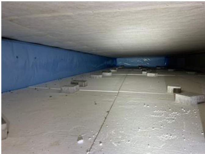
Bilden visar del av krypgrunden.
