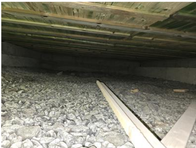
Överblick del av krypgrunden.
