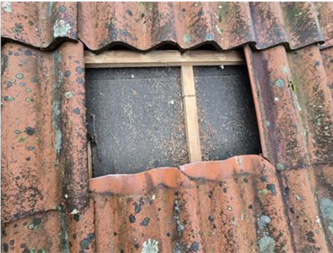
Tak: Stickprovskontroll under pannor ursprungstak.
