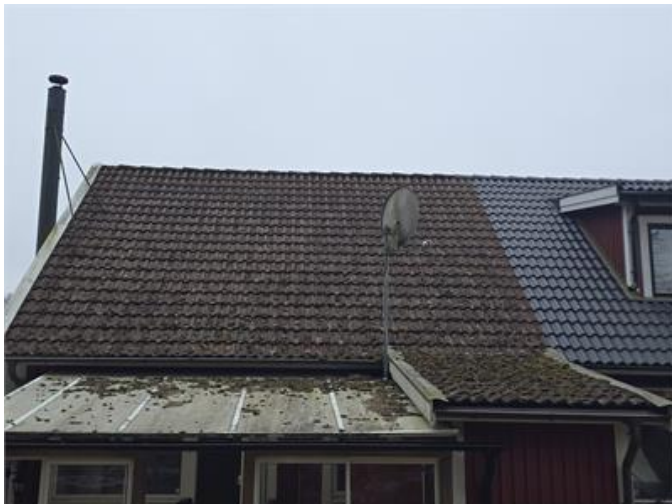
Överblick yttertak, baksidan.
