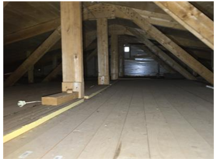
Nockvind: Översiktsbild mot söder, plast noteras bakom panel på gavelspets.
