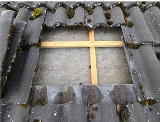
Tak: Stickprovskontroll under pannor utan anmärkning.
