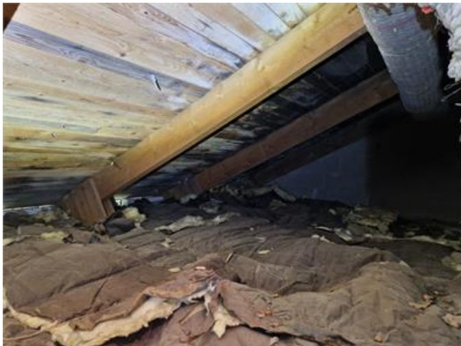
Vy på vindsutrymmet
