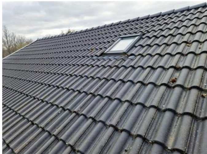
Vy på yttertak
