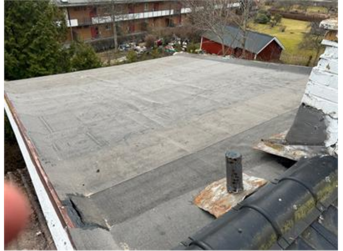
Takkupa som endast är täckt med underlagspapp.
