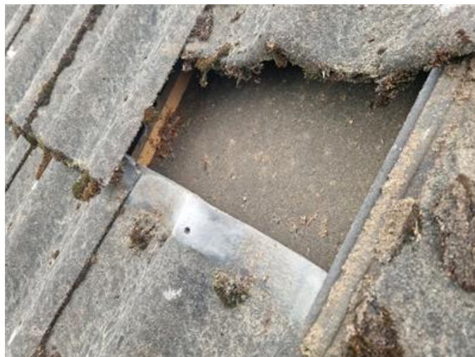
Vy på underlagstak
