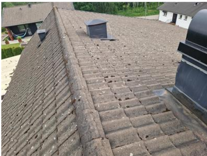
Vy på yttertak
