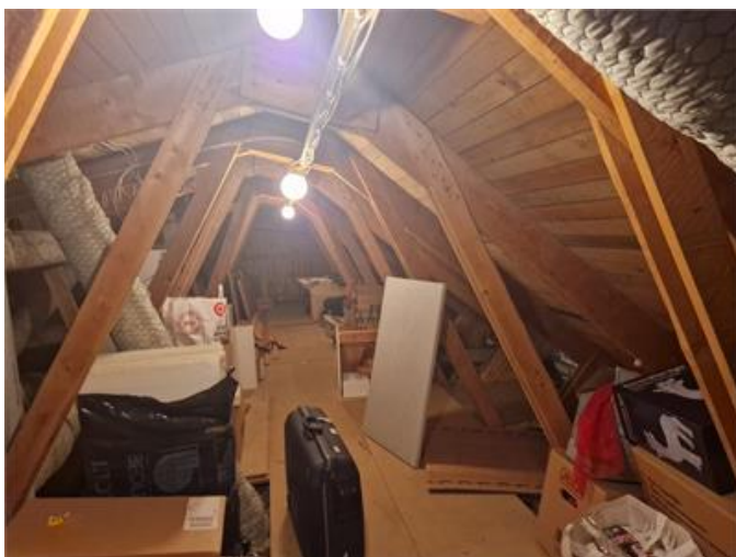
Vy på vindsutrymmet
