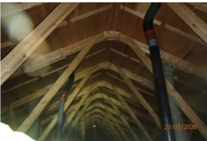
O-isolerade rör på vinden
