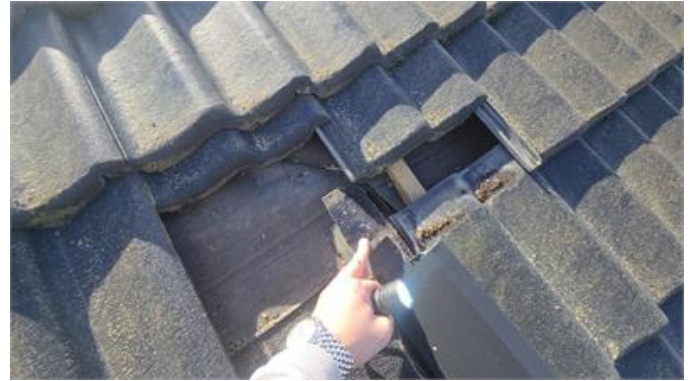
Exempelbild, otätheter mellan taktyper/vinklar (under takpannorna)
