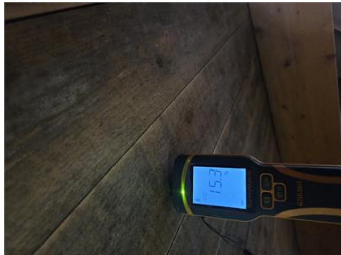
Bild från vindsutrymmet.
