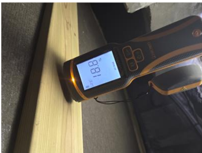
Bild från krypgrunden.
