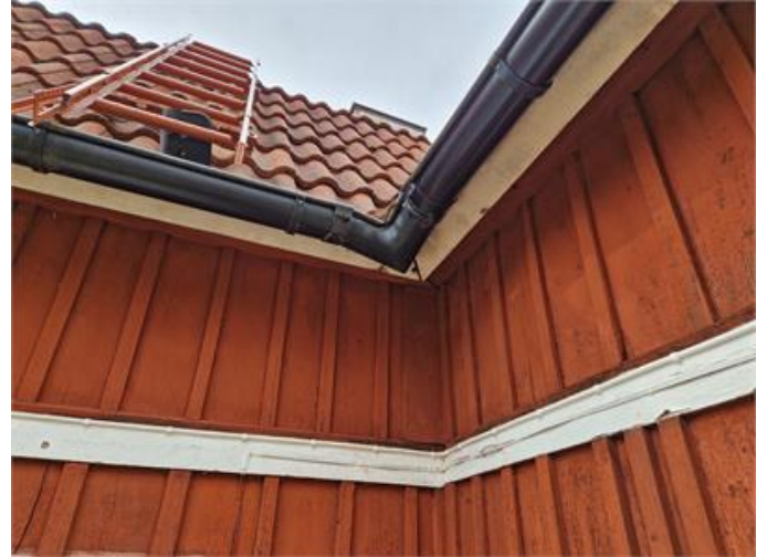
Hängrännor och Stuprör: Lokalt bakfall noterades på hängränna.
