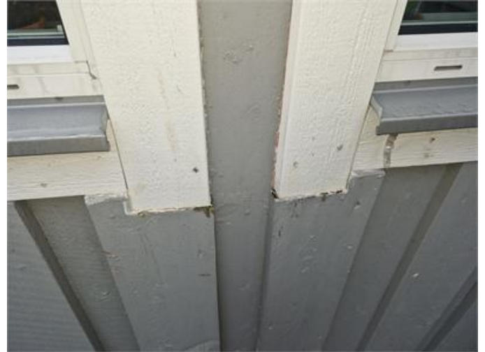
Fasad, ogynnsamma möten mellan panel och foder.
