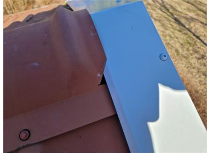
Tak: Otätheter förekommer mellan plåtdetaljer
