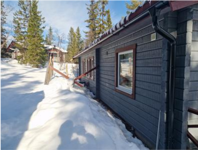
Fasad och fönster.
