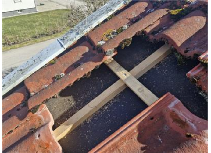
Tak, kontroll under pannor.
