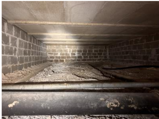
Bild visar del av krypgrunden.
