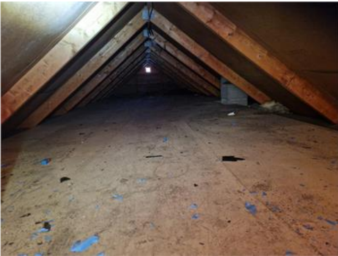
Vy på vindsutrymmet
