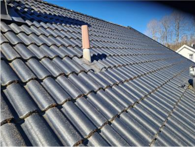
Vy på yttertak
